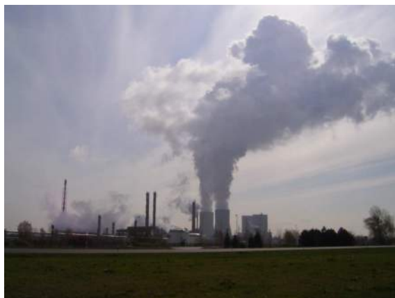
Abbildung 4.7: Fotografische Aufnahme des Kraftwerk Lippendorf von der Messstelle 4.
